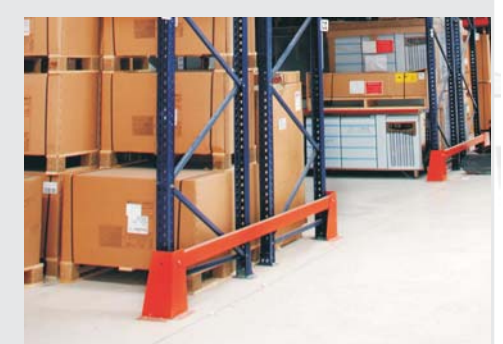
Protector: protege los puntales de la entreplanta del posible golpe de las carretillas.
