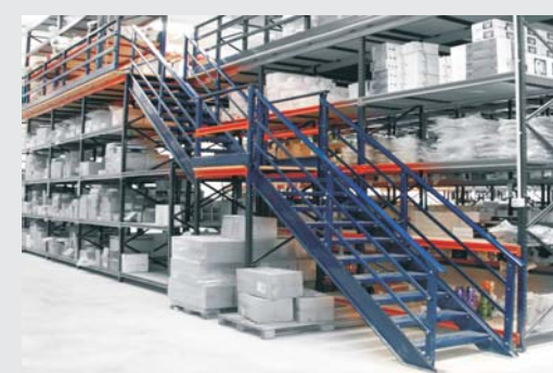
Escalera: Se sitúa en las entreplantas para el desplazamiento del personal.
